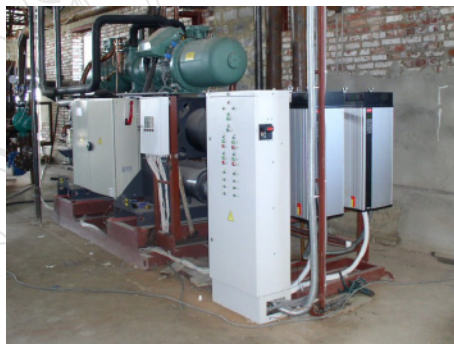
Щит для керування тепловим насосом
