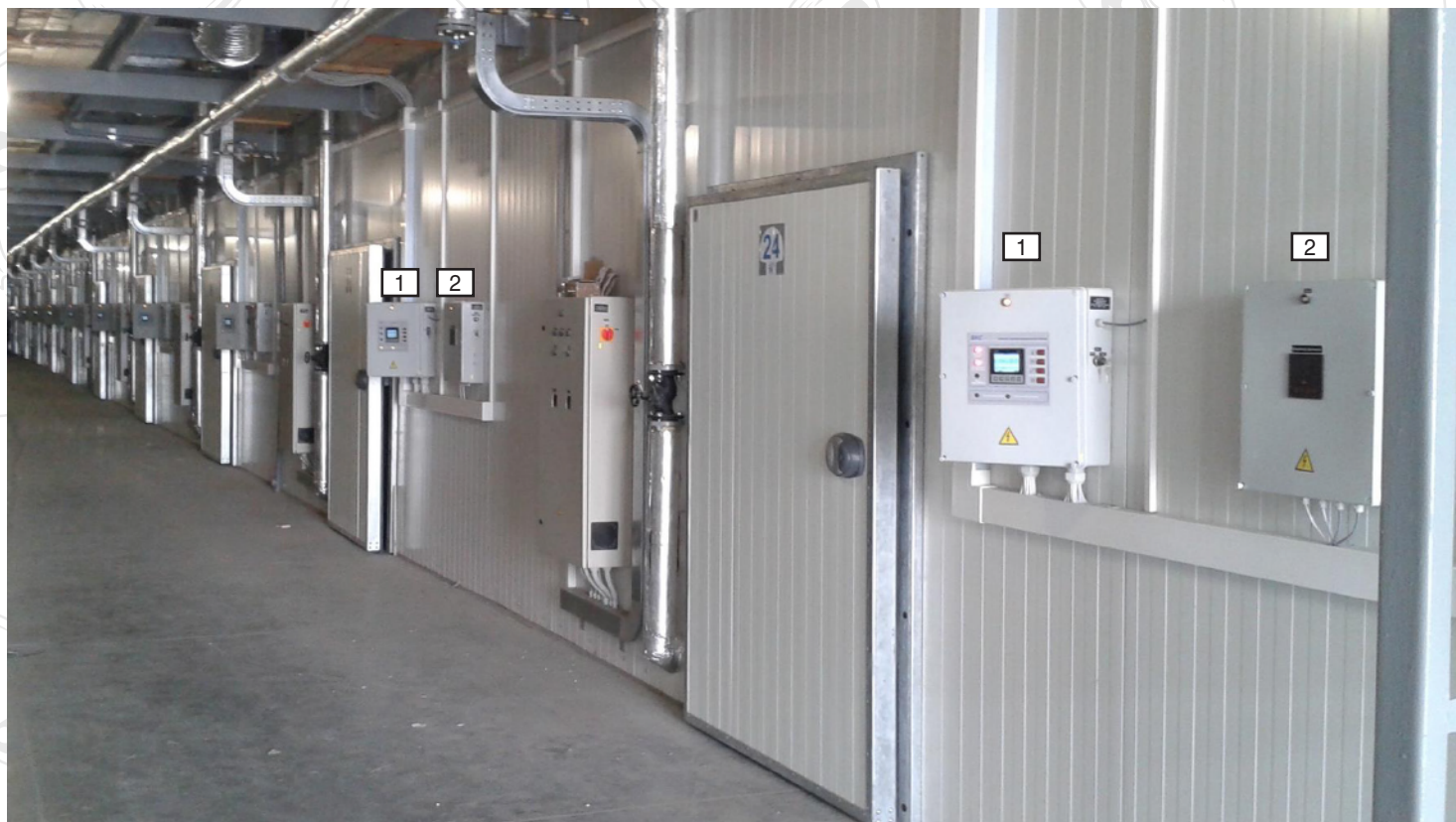
1 - Контролер АКС для промислового вирощування грибів 2 - Пульт CO2 та тиску
